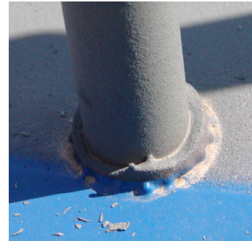
Ansicht guter Keramikringbolzenschweißung mit Hubzündung
