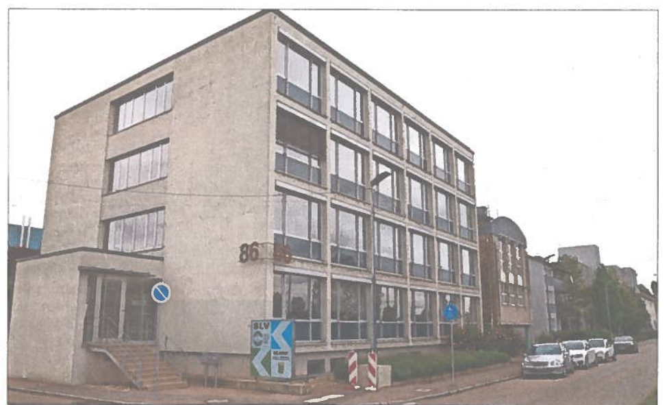
Das Gebäude der SLV in der Stuttgarter Straße ist in die Jahre gekommen.
