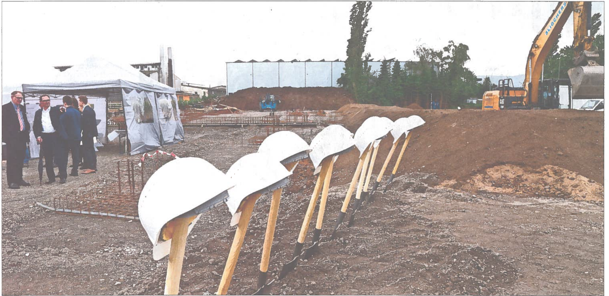
Zuversicht beim symbolischen ersten Spatenstich auf der Baustelle der Schweißtechnischen Lehr- und Versuchsanstalt: Im Juli 2017 soll die neue Halle fertig sein.
