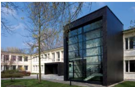
Der neue Hörsaalkomplex der SLV Halle
