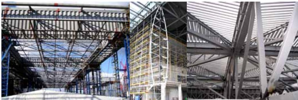
links: Fluggastterminal im Bau, mitte: Seilbinder-Fassade, rechts: Dachtragwerk
