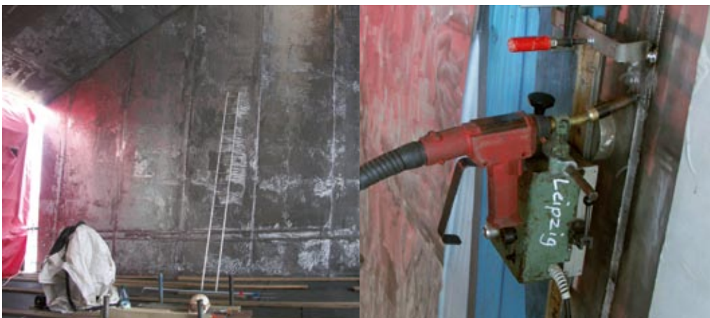
Einsatz des MSG-Schweißens unter Montagebedingungen in der REA Boxberg Block R
