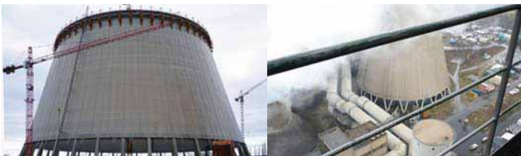
Baustelle des Kraftwerkes in Duisburg-Walsum
