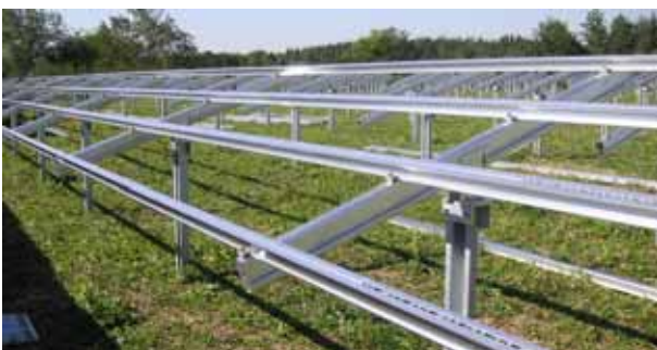
Systemverbindungen als Halterungen für Sonnenkollektoren
