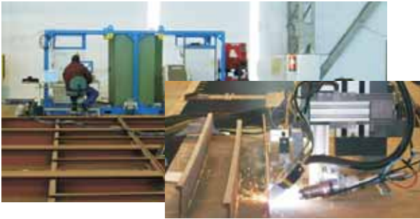
10 kW Faserlaser der SLV Mecklenburg-Vorpommern und Traktor zum Hybridschweißen in der Werfterprobung während des Projektes Dock-Laser
