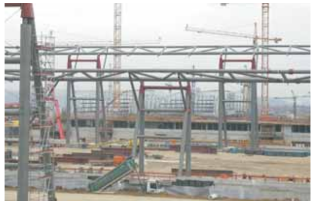
Neue Messe Stuttgart – Montage der Standardhalle A 1 mit dem Parkhaus über die BAB 8 im Hintergrund
