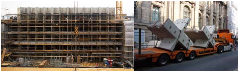
Rohbau - Neuer Lesesaal der Staatsbibliothek (links), Anlieferung geschweißter Fertigteile (rechts).
